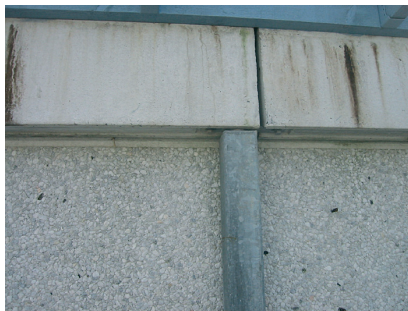
Figur 2. Galvaniseret stolpe med påsvejt plade foroven, som bærer en betondrager.
