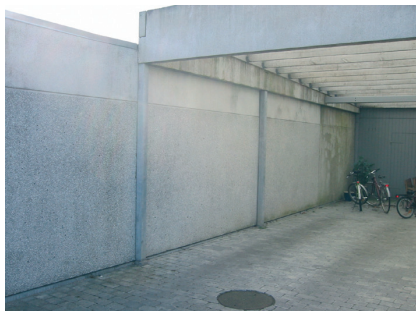
Figur 1. Galvaniseret, lukket, bærende stolpe nedstøbt i beton.
